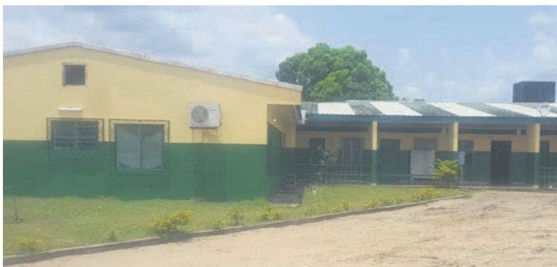
La façade du centre hospitalier réhabilité DR
