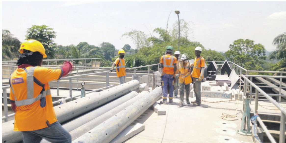
Des techniciens à pied d'oeuvre/Adiac
