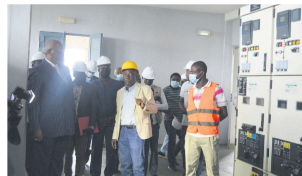
Hugues Nguélonzé visitant la centrale électrique Adiac
