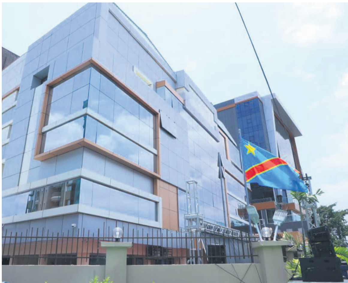
Le nouveau bâtiment de la Cenaref/DR
