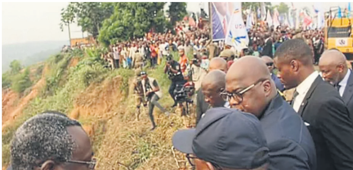
Félix Tshisekedi donne le go des travaux de lutte antiérosive à Kananga/DR
