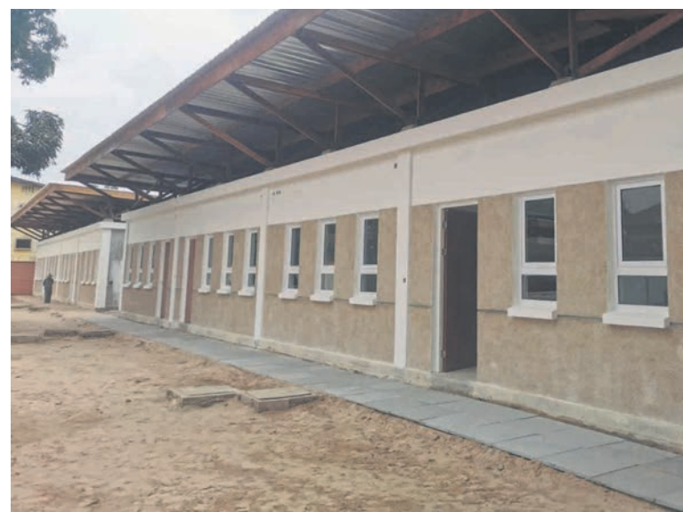
Travaux d'élargissement du lycée Saint-Exupéry/Adiac
