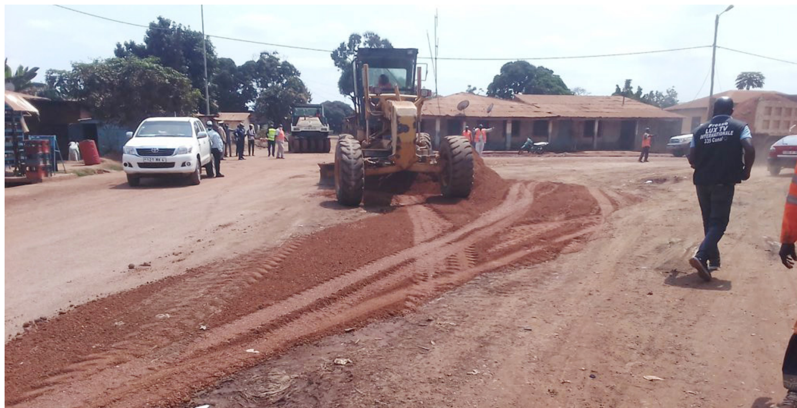
Les engins en pleins travaux/Adiac
