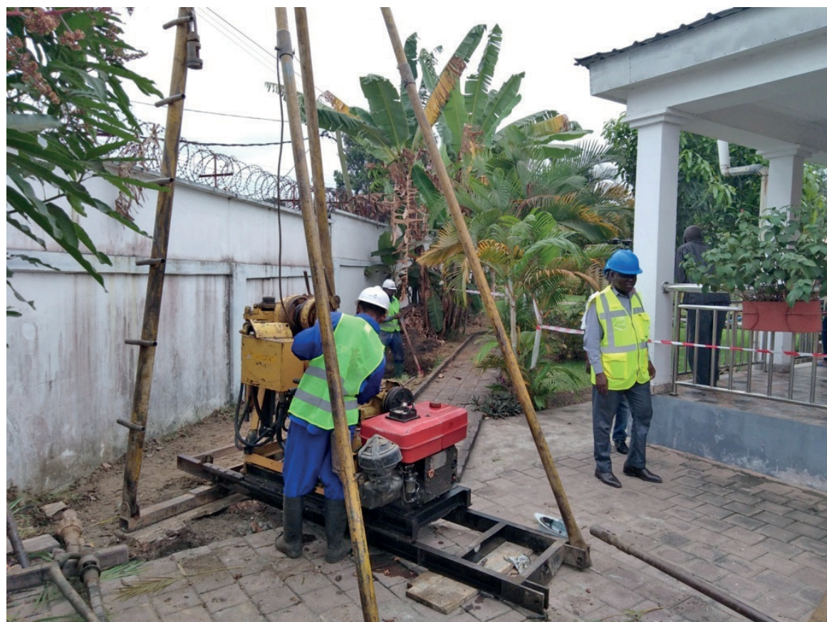
Début des travaux de construction du forage/Adiac
