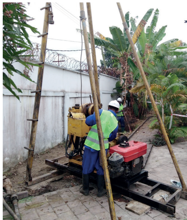
Début des travaux de construction du forage
