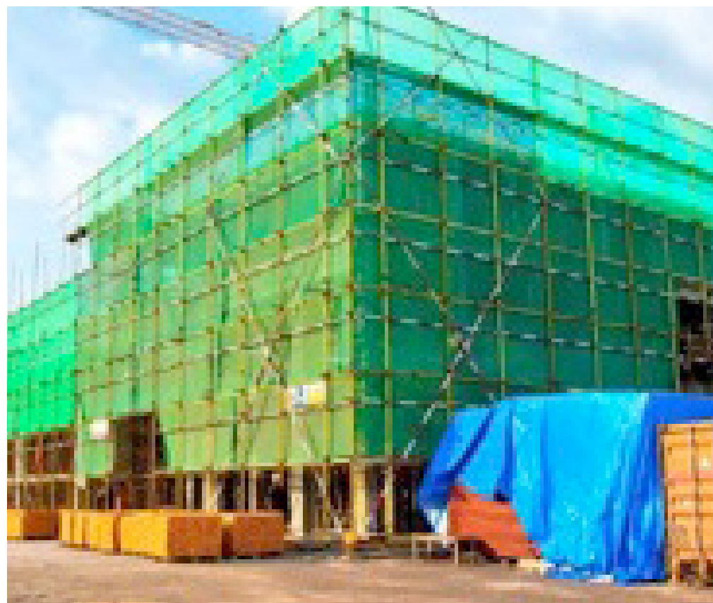
Le chantier au début des travaux
