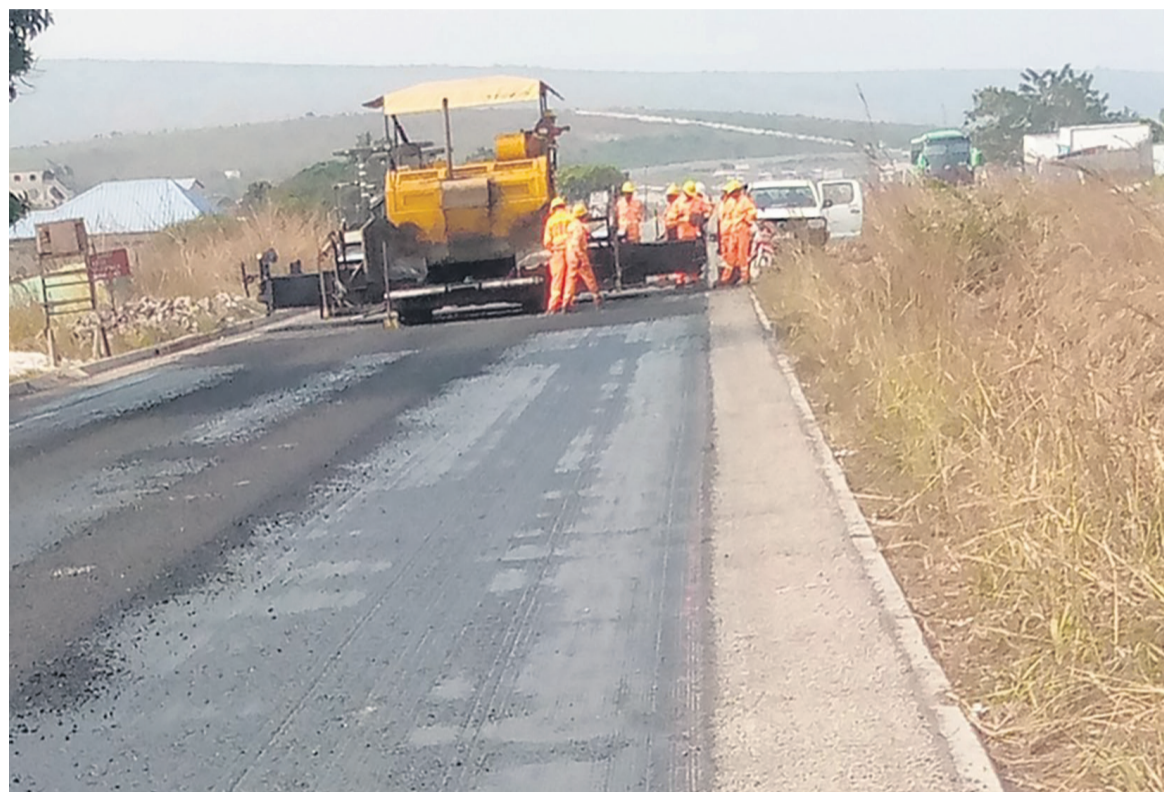
La surface de la chaussée renouvelée/Adiac
