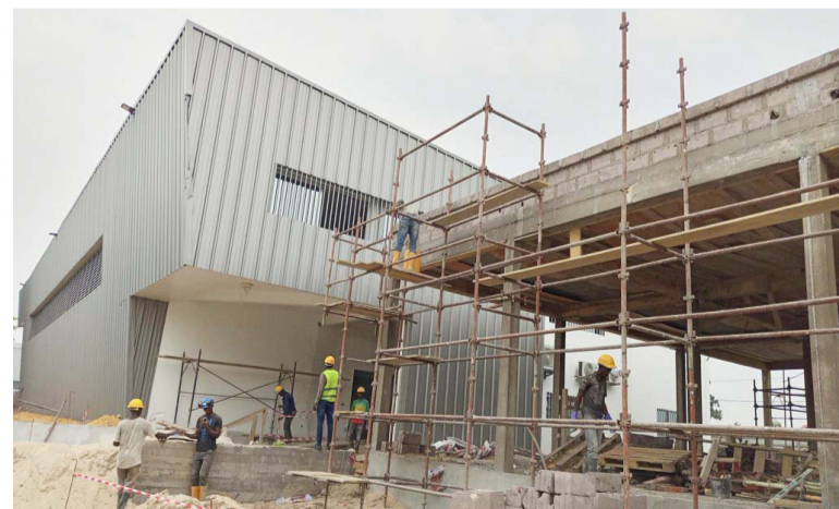
Une vue partielle du chantier
