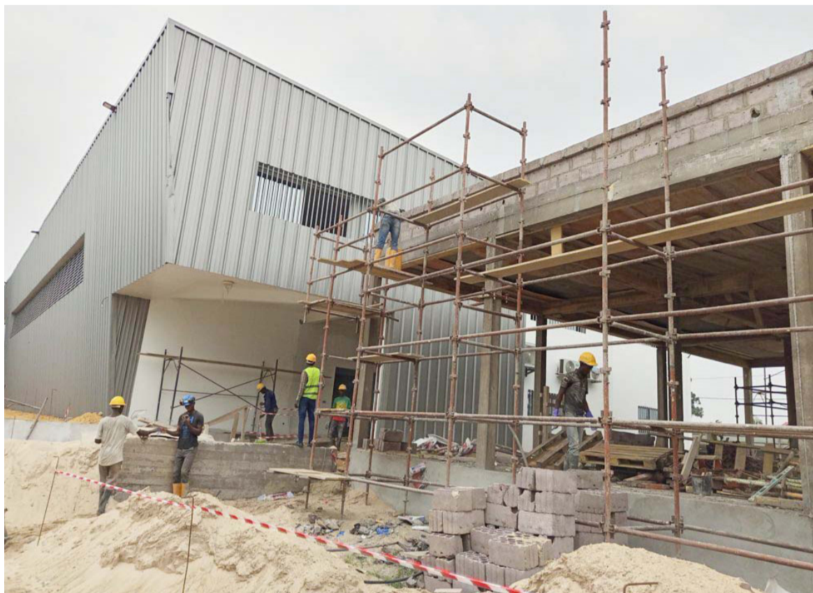
Une vue partielle du chantier
