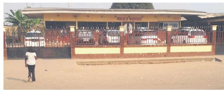
Une vue de la morgue de Makélékélé/Adiac quartiers périphériques, mais qui sont aussi à l'origine de nombreux accidents de circulation routière », a souligné le président du Conseil départemental et municipal de Brazzaville, Dieu-donné Bantsimba.
