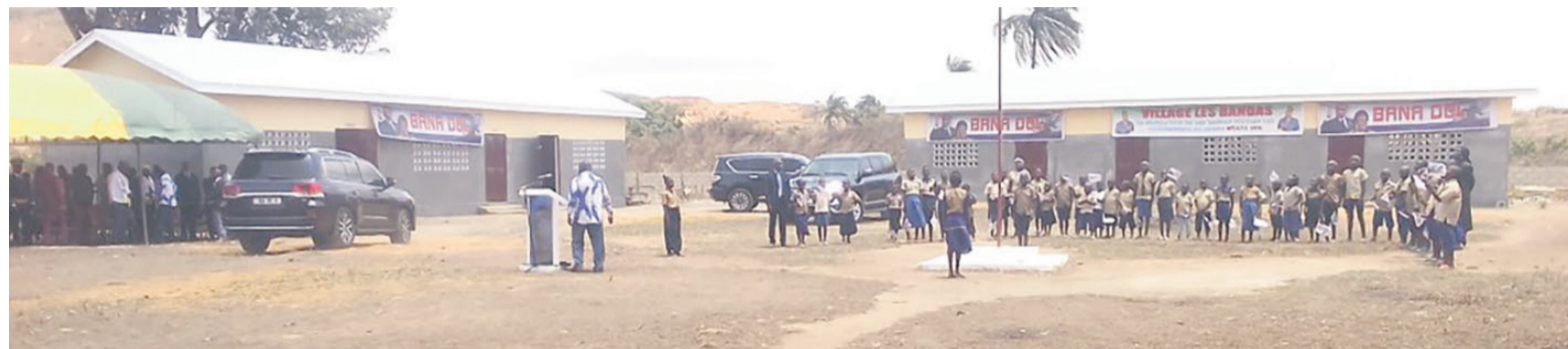
Une vue de l'école du village Moukondo rénovée/Adiac
