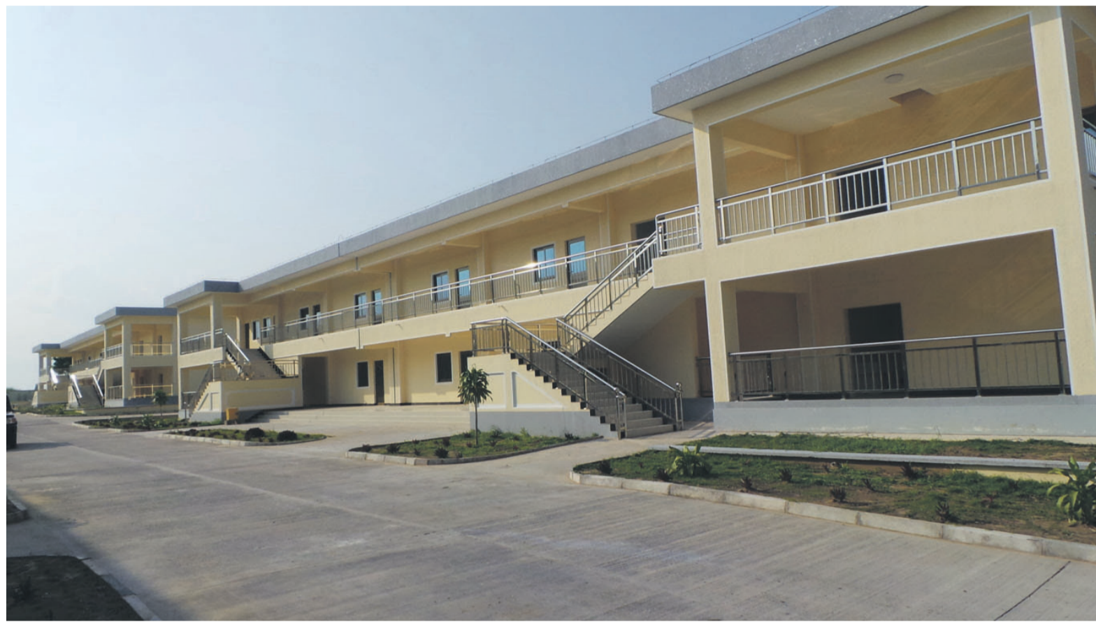
Un bâtiment à la caserne Ndouo/DR
