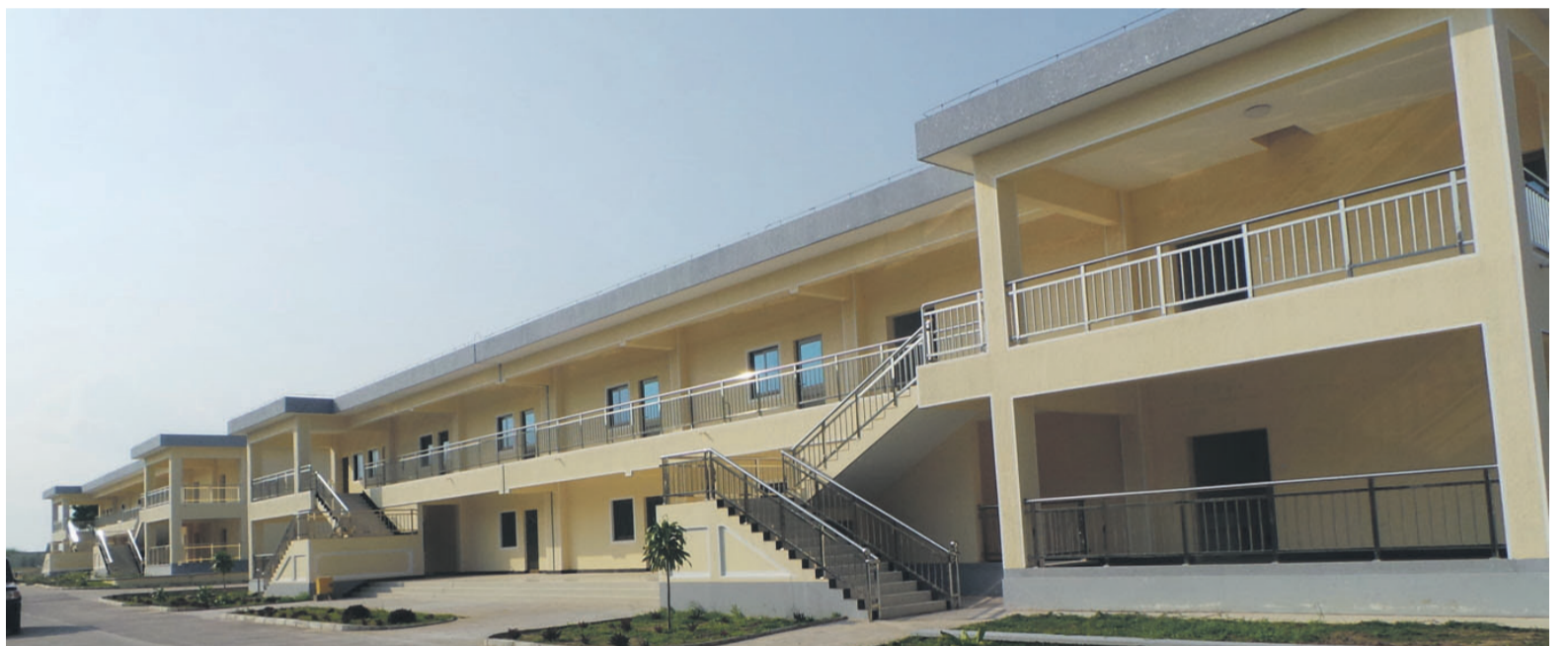
Un bâtiment à la caserne Ndouo/DR
