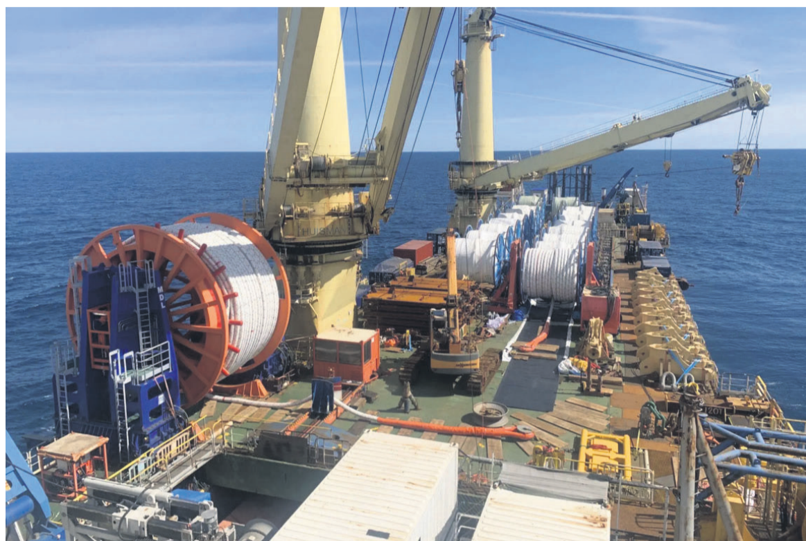
L'opération de déchargement des câbles à fibre optique au Terminal de Pointe-Noire/DR
