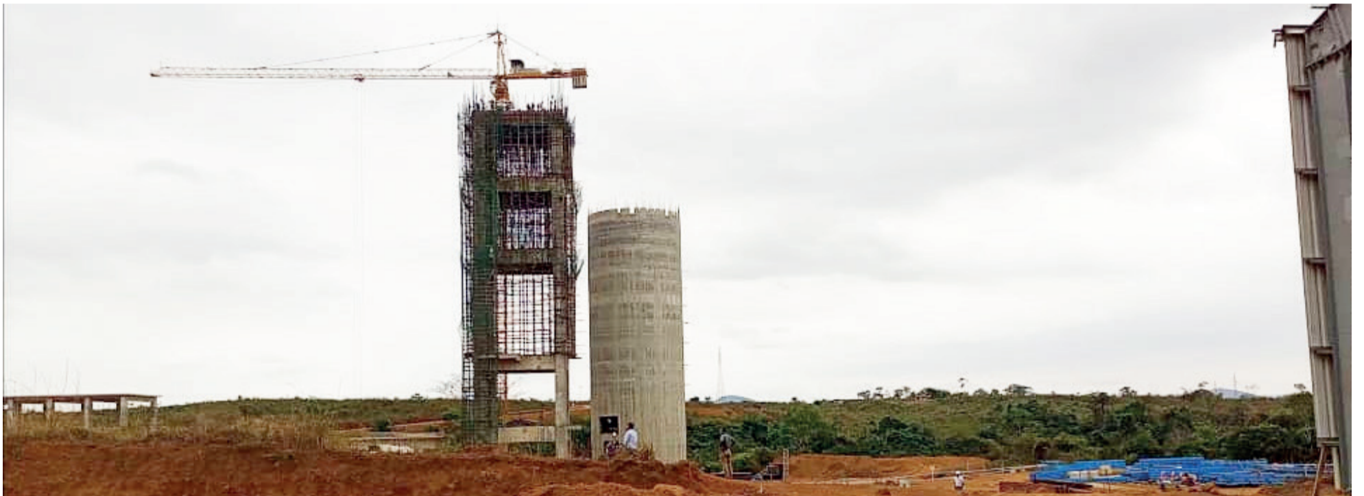
Une vue des travaux déjà réalisés DR
