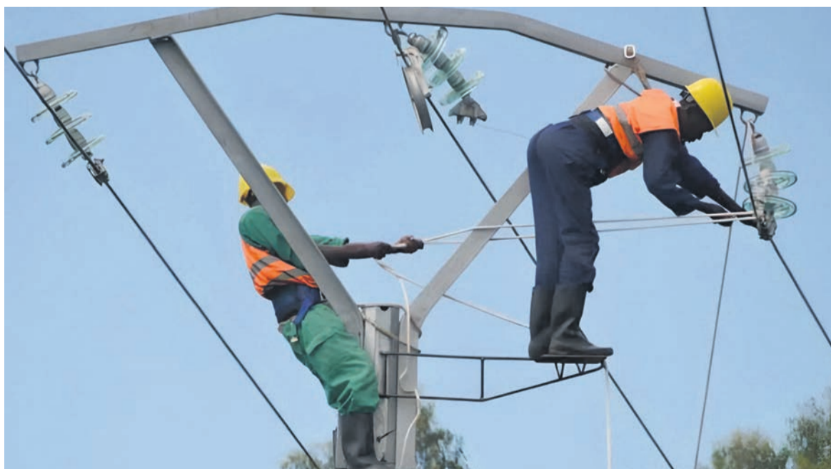
Les agents du Virunga énergie entrain de rétablir l'électricitéDR.
