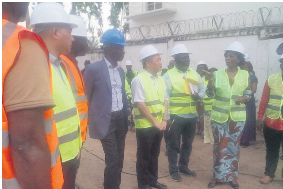
La ministre Arlette Soudan-Nonault et l'équipe des constructeurs sur le chantier de la RTBC/Adiac
