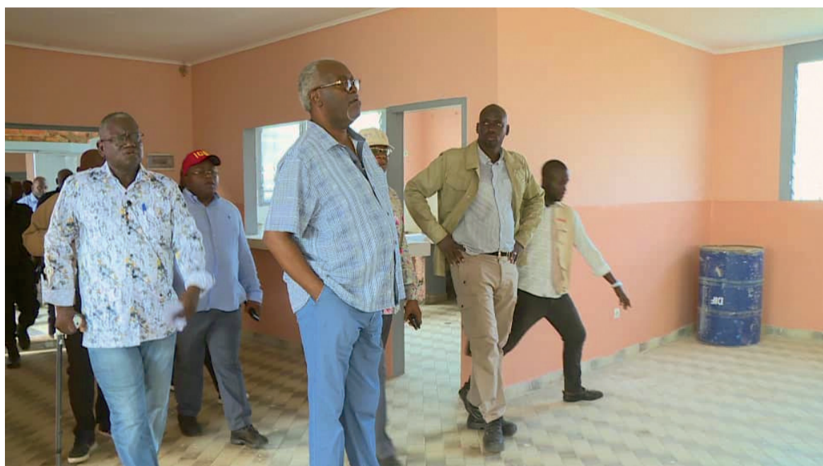
Hugues Ngouélondélé visitant le chantier d'Aubeville/Adiac
