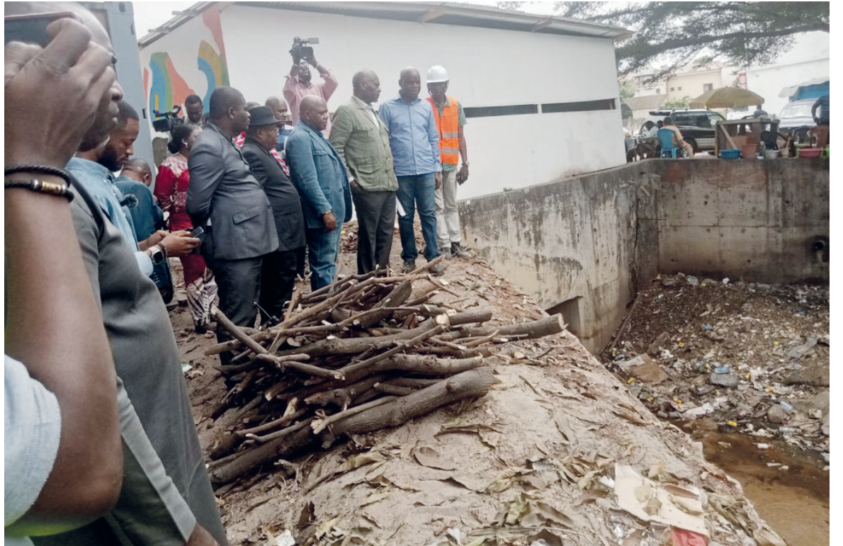
Le député-maire Bantsimba visitant les travaux de curage du collecteur situé en face de la BSCA Bank/Adiac
