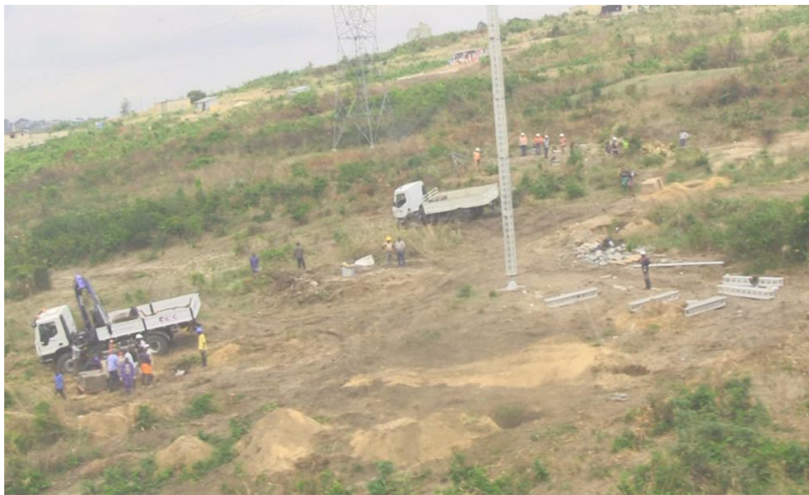
Les techniciens de E 2 C à pied d'œuvre sur le terrain DR
