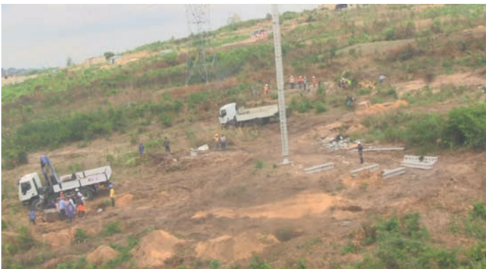
Les techniciens de E2C à pied d'œuvre sur le terrain/DR
