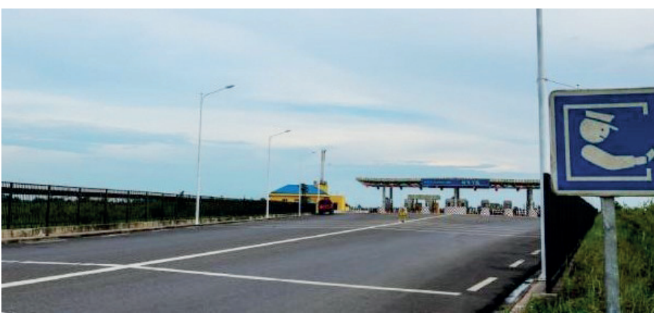
L'installation de l'un des sept péages en service/DR
