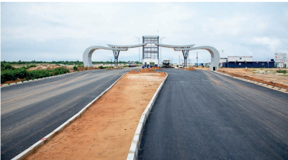
La vue d'une voirie aménagée à la ZES de Pointe-Noire/DR
