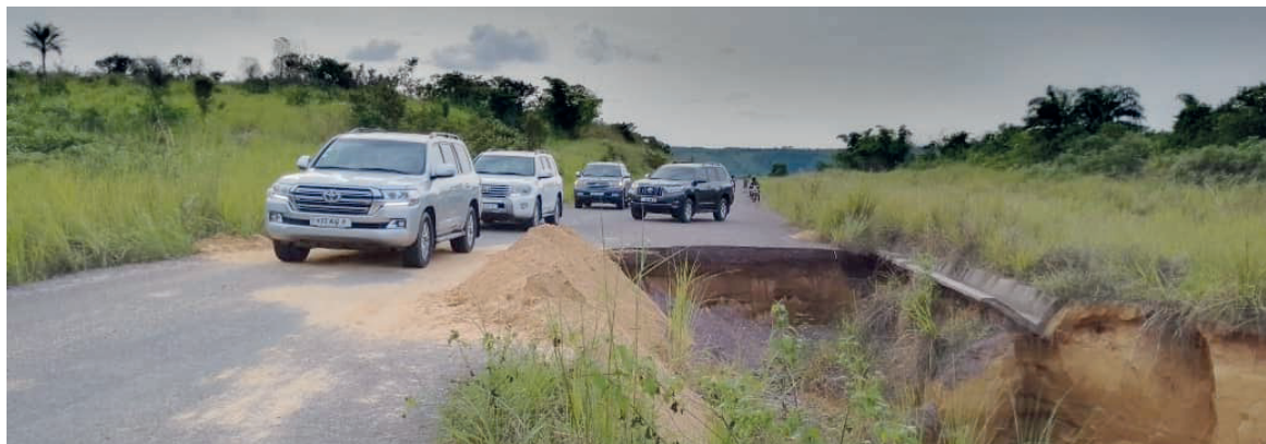
L'érosion menaçant le tronçon Kinkala-Gambari/Adiac
